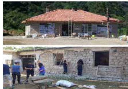
Şekil 7. Gürsu Taş Mektep Onarımdan Sonra 3 , Paçva Taş Mektep Onarılırken 4
